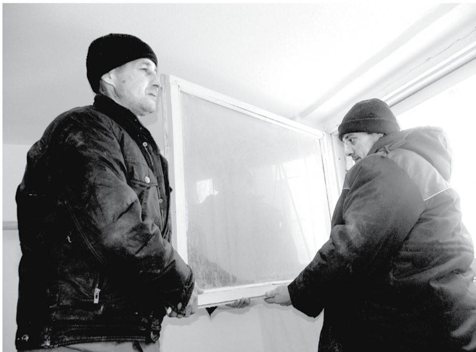
Остеклением подъездных оконных блоков, которые позволяют сохранить тепло в домах, активно занимаются работники ЗАО «ПМК-2» Олег Нуритдинов и Александр Артамонов.
