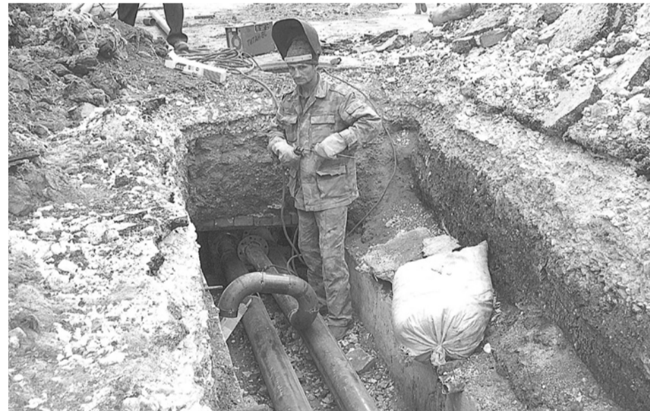
Капитальный ремонт наружной системы отопления на Гагарина, 10, ведут строители ООО «УралБиоГаз». На снимке И.В. Копылов.
