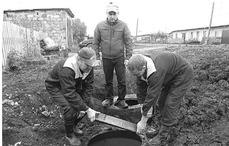
Монтажом одного из водопроводных колодезев на ул. Юбилейной занимаются газосварщик ООО «Водоканал» Анатолий Венедиктов и слесарь Леонид Пастухов под руководством Дмитрия Ситникова (в центре).
