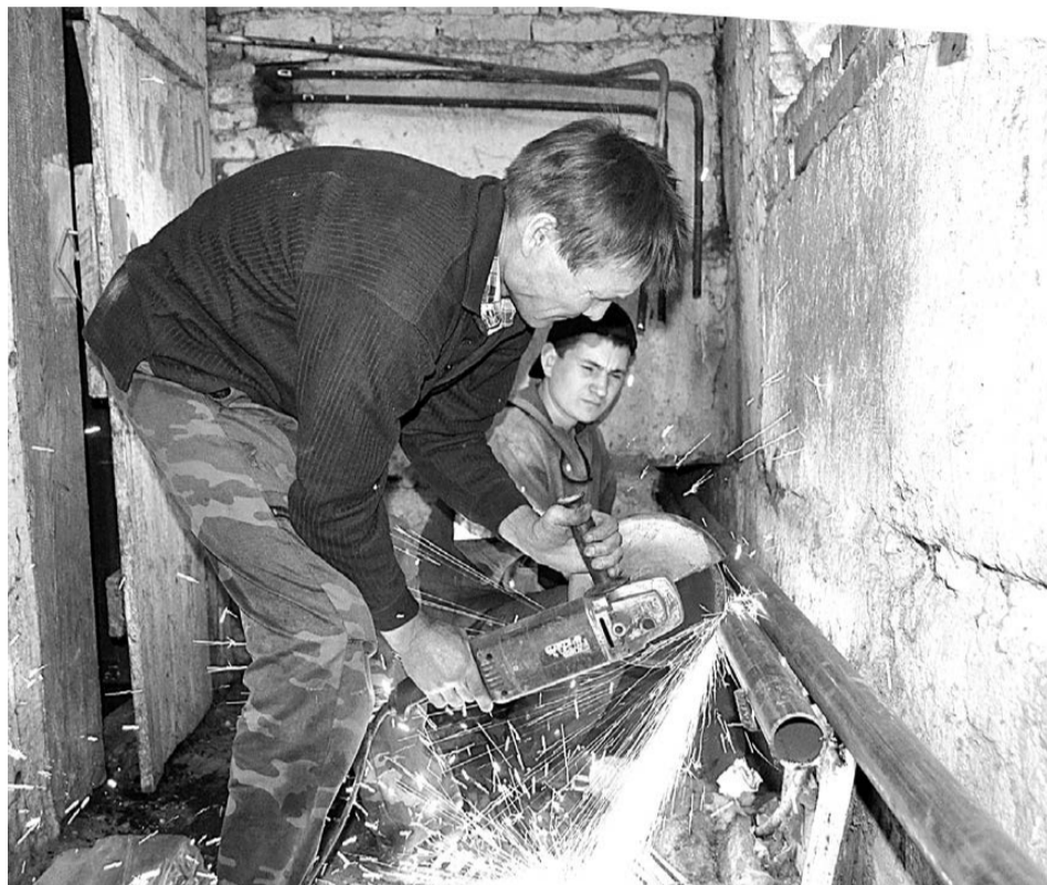
Работники ООО «Жилье» Владимир Кораблев и Алексей Пургин ведут монтаж системы центрального отопления в подвале дома № 27 на улице Первомайской.
