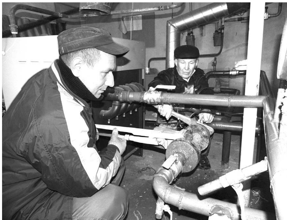
Работники МУП «БТС» Семен Никитин и Павел Тушков завершают ремонт мини-котельной детсада №9.
