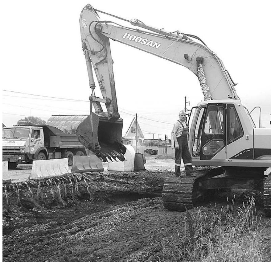
Ударно трудится на ремонте дороги экскаваторщик Андрей Колчин.
