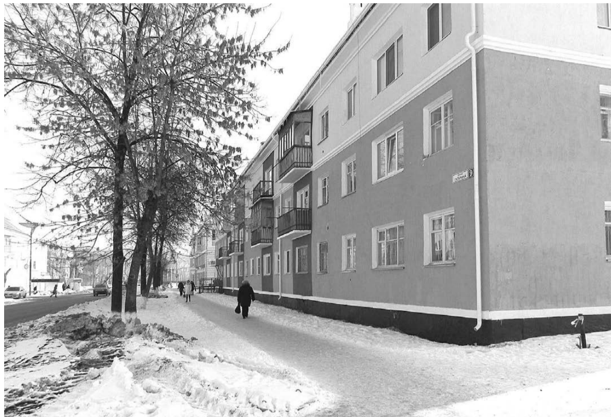
Дома на улице Гагарина после капитального ремонта по закону № 185-ФЗ.
