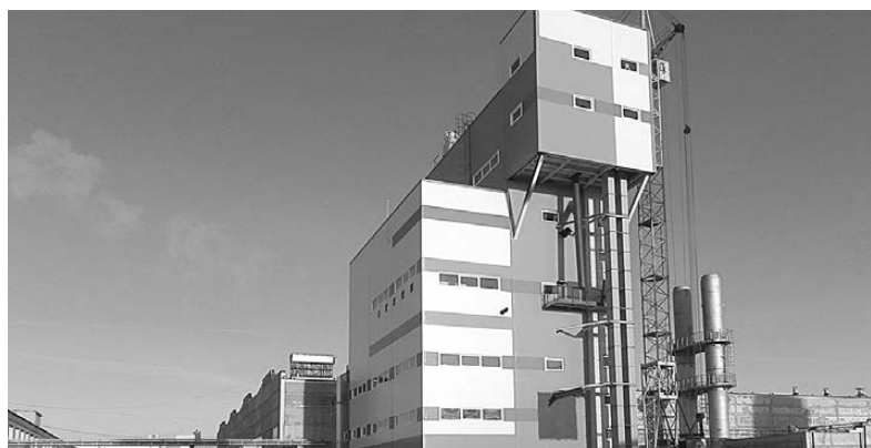
Технологическое оборудование завода смонтировано полностью.
