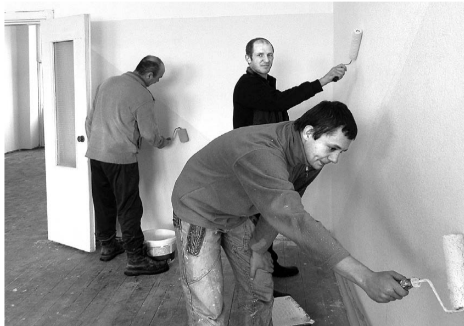
Строители В.А. Шпендик, А.С. Павлов и А.Н. Сутягин ведут покраску стен будущей группы.
