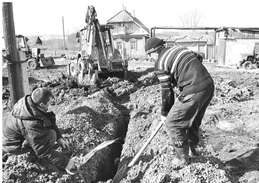
Работники ООО «Мехмонтаж» зарывают траншею на ул. Советской.
