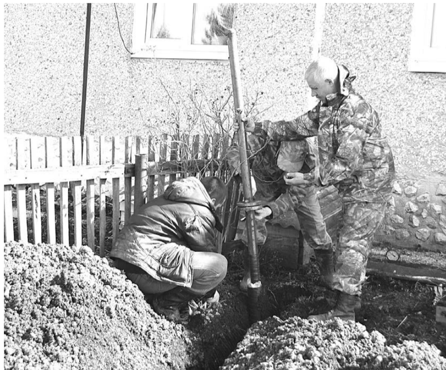
Бригада Александра Быковских (справа) устанавливает трубу выхода газопровода у дома № 8 на ул. Советской.
