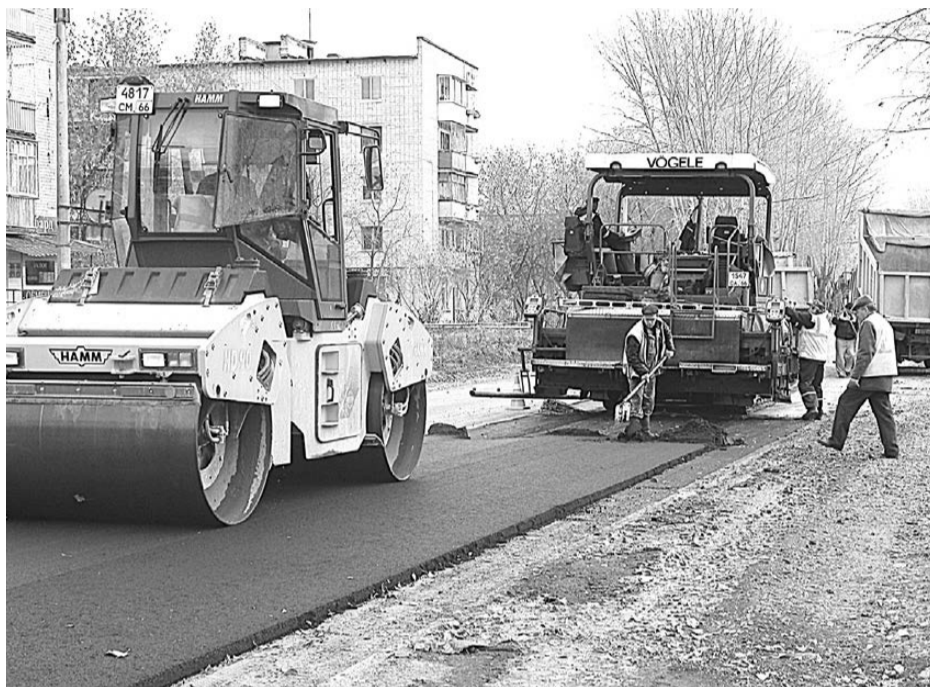
Работники «Свердловскавтодора» укладывают верхний слой асфальтобетона на улице Кунавина.
