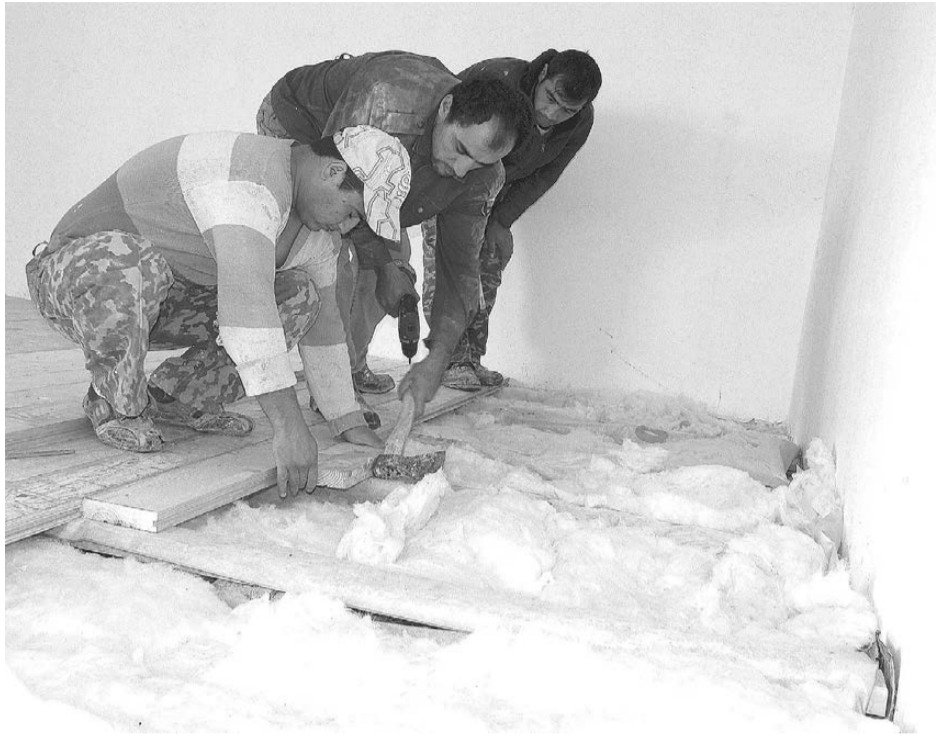
Строители ООО «Строймонтаж Урал-2000» ведут укладку пола.
