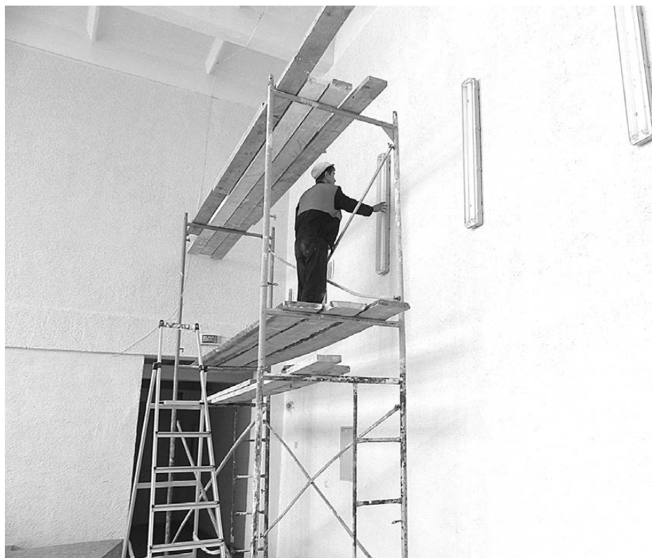
Ремонт актового зала школы № 2 идет к концу.
