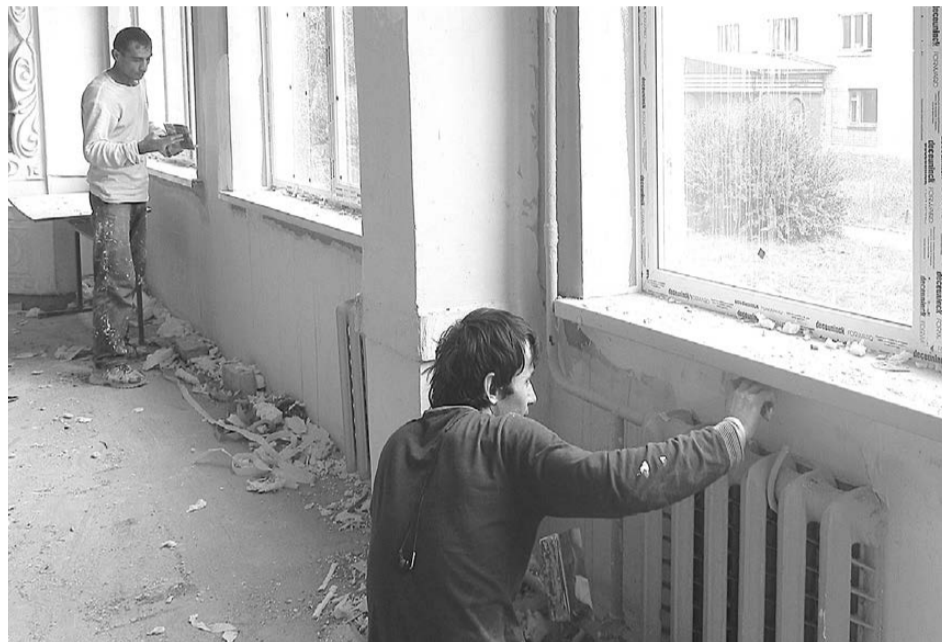
В учебных кабинетах кадетской школы полным ходом идет ремонт.
