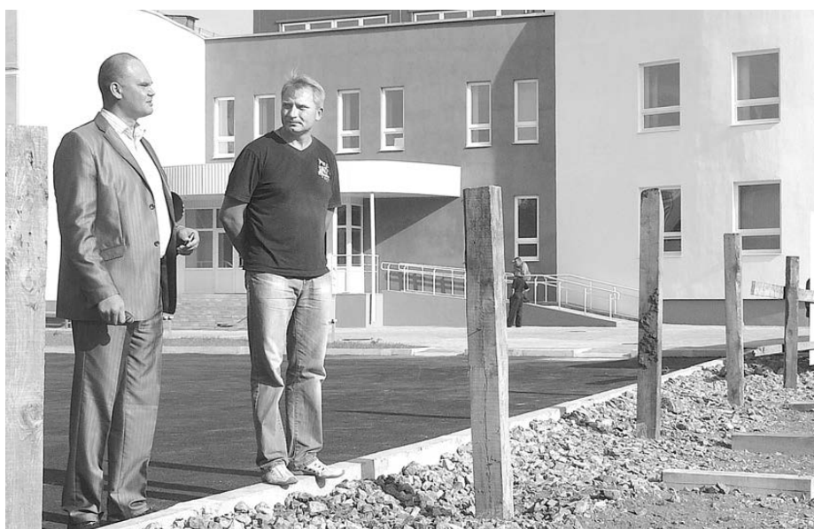
М.В. Кожевнин и С.А. Черненко осматривают площадку второй очереди спорткомплекса.
