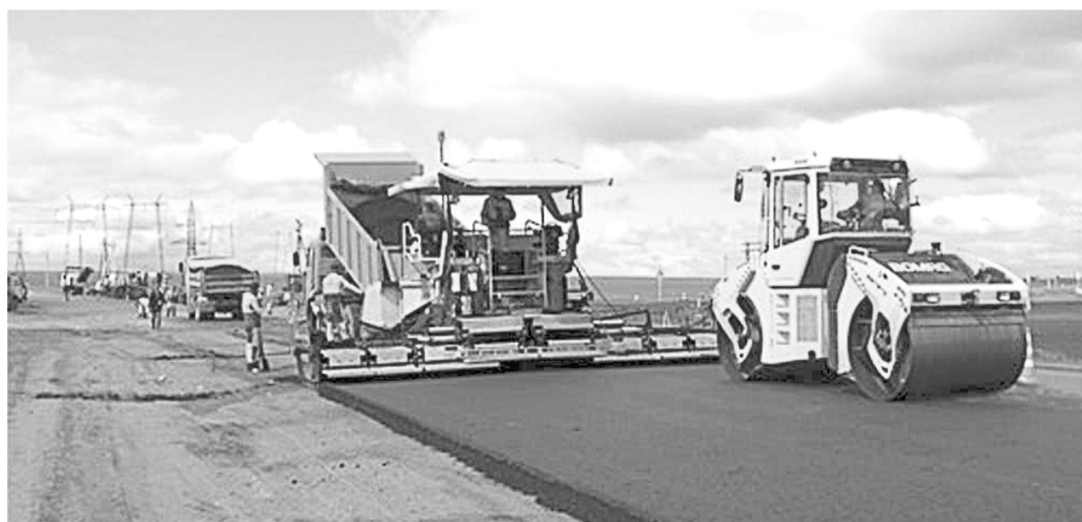
На автодорогах области ведутся ремонтные работы.
