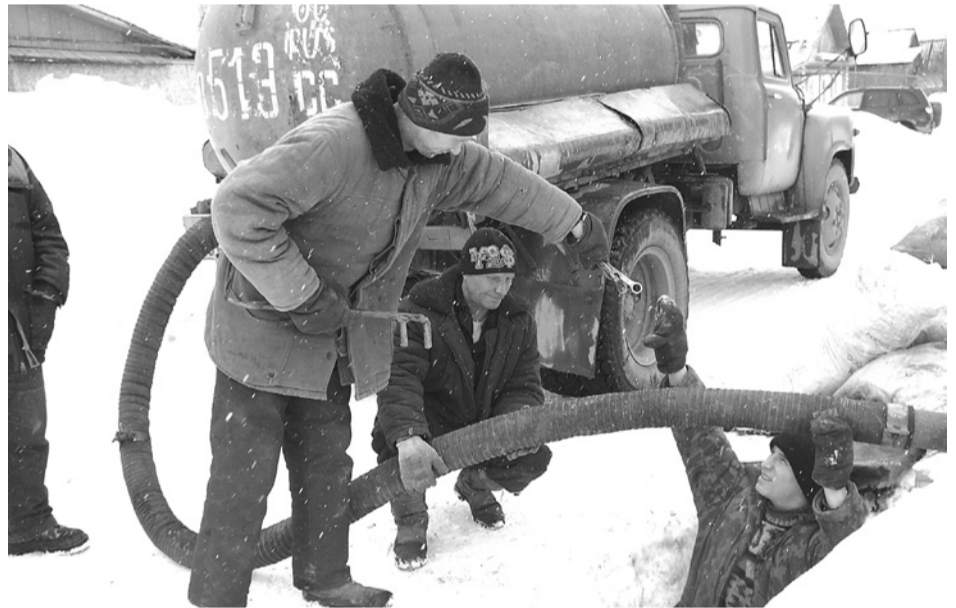
Отогревом колодца ХВС занимаются работники ООО «Водоканал» О.В. Пургин, В.А. Смирнов и А.А. Демин.
