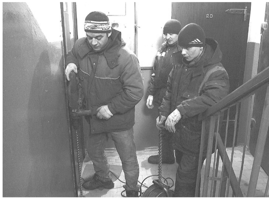
Стояк для прокладки компьютерного кабеля монтируют работники ОАО «Связьмон-тажстрой» А.В. Шайтер, С.В. Борчанинов и И.П. Чирков.
