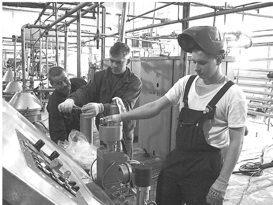
Монтаж гомогенизатора производят А.П. Кашкин, А.Г. Щербаков и А.М. Телегин.
