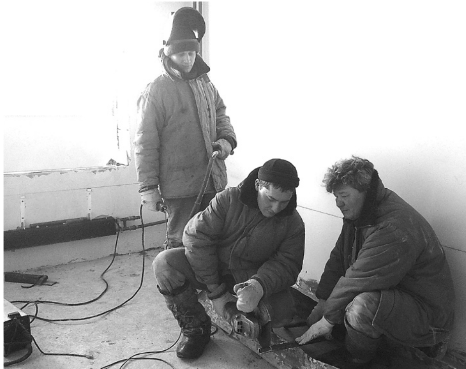
Монтаж системы отопления в доме N 9 на ул. Кунавина ведут работники ЗАО «ПМК-2» А.Н. Головин, В.С. Зуев и А.В. Разницын.
