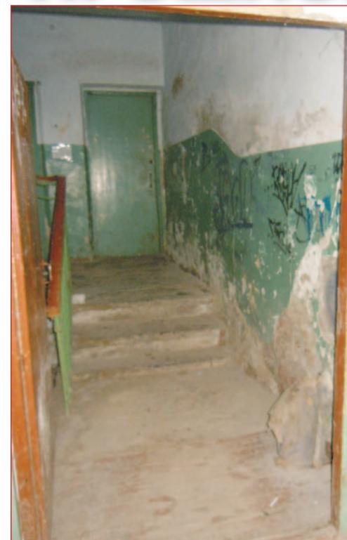
невозможно дышать от того, что канализационные трубы текут уже не первый год, подвальный запах гнили идет в комнаты. Отопительные трубы выглядят ржавыми и изношенными, к тому же, очень хрупкими. О покраске стен в подъезде здесь уже давно и не мечтают, лестница разбита, а пол на лестничных пролетах изрядно износился.
