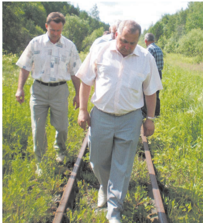
Министр Г. Маренков знакомится с техническим состоянием путей АУЖД
