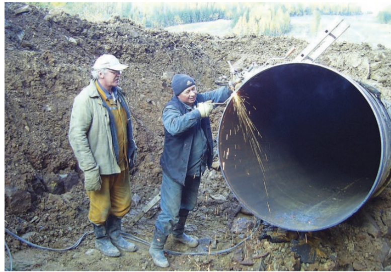
Работники службы ЛЭС подготавливают трубу к сварке.
