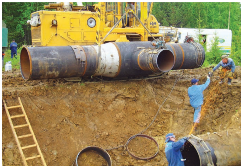
Производится установка «тройника» в газопровод.
