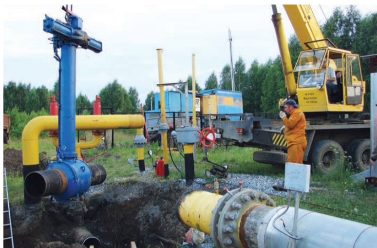
Монтаж запорной арматуры.
