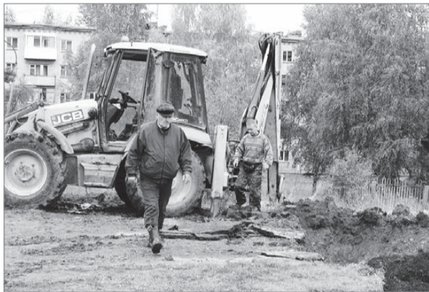
Работы ведет ООО «ЮнивестСтрой».
