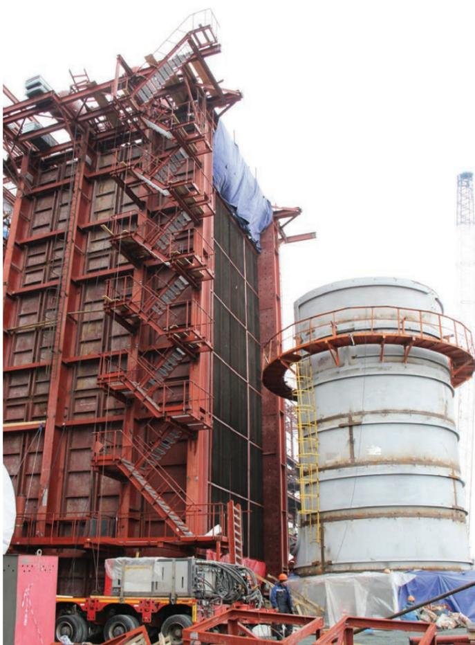
Завершается монтаж котла-утилизатора и основания трубы.
