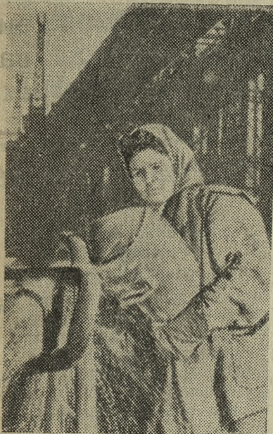
Волгодонстрой. На строительстве Димлянского гидроузла работает электросварщица Августа Иванова Сергиенко — участница многих троек в нашей стране. Здесь на варке арматуры для бетонирования основания Цимлянской ГЭС, она систематически выполняет не менее двух с половиной норм в смену.
