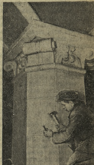
Строительство 4-й очереди Московского метрополитена. Мраморщик А. Захаров за отделкой колонны станции «Комсомольская».
