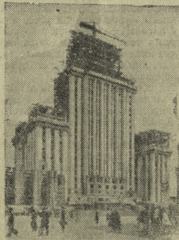
Москва. Строительство высотного административного здания на Смоленской площади. Фото Н. Грановского.
