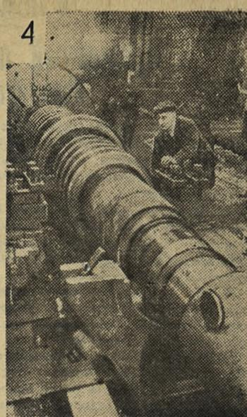
новом паротурбинном цехе идет механическая обработка ротора высокого давления.
