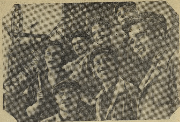
Сталинская область. На заводе «Азовсталь» на месяц раньше срока закончено строительство новой доменной печи.
