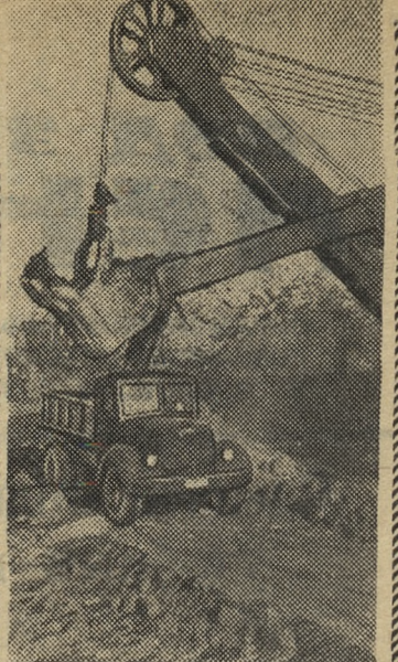
Пермская область. Быстрыми темпами сооружается Воткинская ГЭС. За минувший год строители выполнили почти 10 миллионов кубометров земляных работ, уложили 70 тысяч кубометров бетона и железобетона, смонтировали 2,2 тысячи тонн металлоконструкций. Вдохновленные решениями XXI съезда КПСС, строители стремятся досрочно сдать станцию в эксплуатацию. Задание этого года они решили выполнить к 25 декабря. На снимке: работы в котловане строительства Воткинской ГЭС. Фото Б. Визуля. Фотохроника ТАСС.
