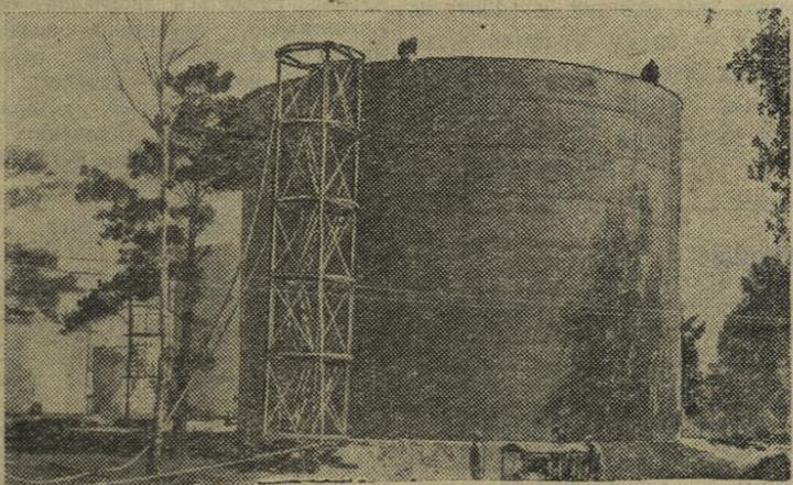
Красноярский край. В районе освоения целинных и залежных земель значительно расширяются емкости нефтяных баз. На снимке: строительство резервуара для светлых нефтепродуктов емкостью 2 тысячи тонн на Ачинской нефтебазе.
