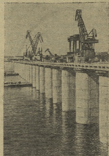
Каховский гидроузел. Водосливная плотина.
