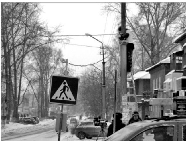
Пешеходный переход на перекрестке улиц Трубников и Герцена оборудовали датчиком движения.
