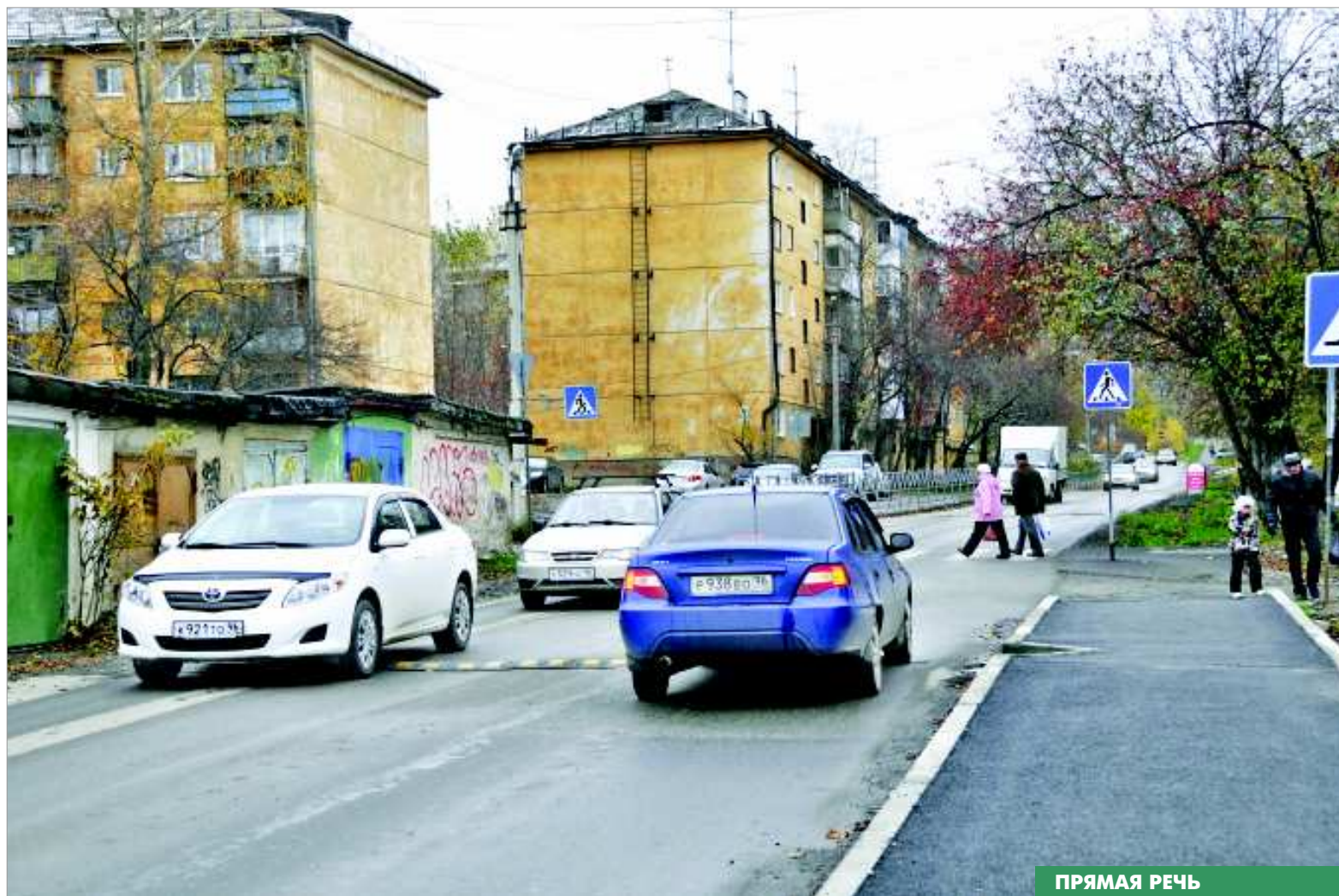
Теперь улица Малышева - от дороги до дворов - отвечает требованиям безопасности.
