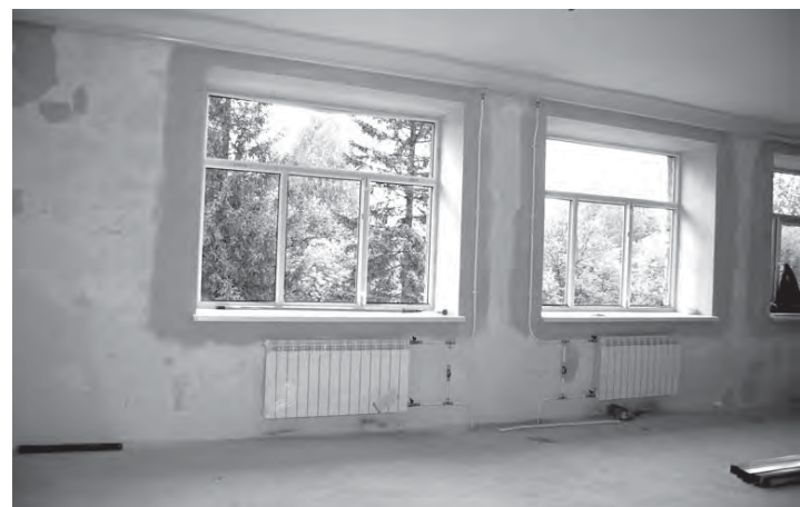
В садике "Лесная сказка" кипит работа – внутри оштукатурено, подведено тепло, заменена электропроводка, старые окна меняются на пластиковые
