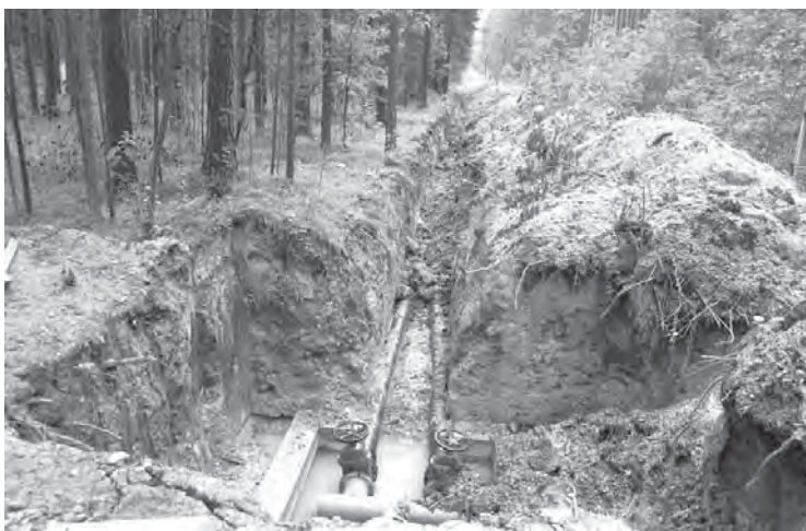
Прокладывается новый водовод
