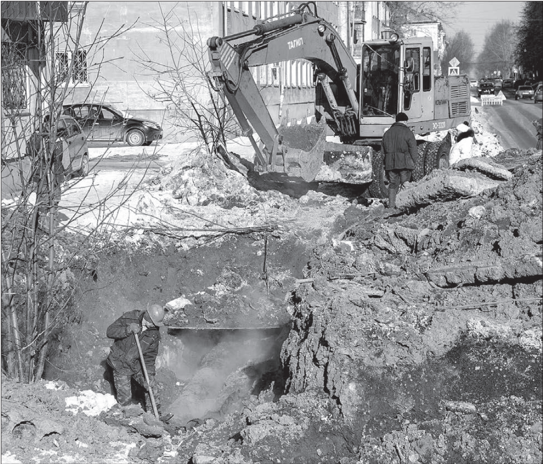
На аварийном участке будут менять трубу.
