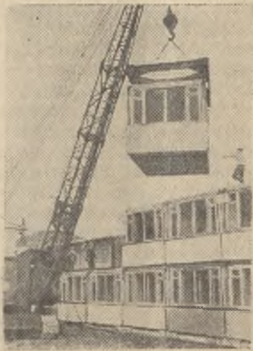
Приморский край. В городе Находке трест „Дальморгидрострой“ возводит жилой дом из объемных монолитных комнат размером 5,17х3,17х2,5 метра. Они изготавливаются из железобетона на специальной домостроительной машине и окончательно отделяются перед доставкой их к месту монтажа.
