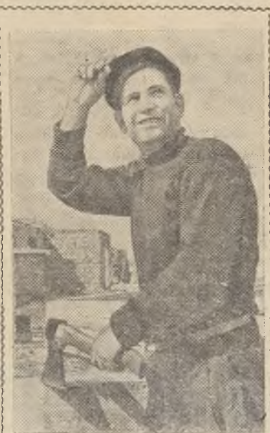
Запорожская область. Колхоз «Ленинская правда» Михайловского района ежегодно ведет большое строительство. На снимке: строительство свинарника в колхозе «Ленинская правда». На переднем плане плотник Александр Попов. Фото А. Красовского. Фотохроника ТАСС.
