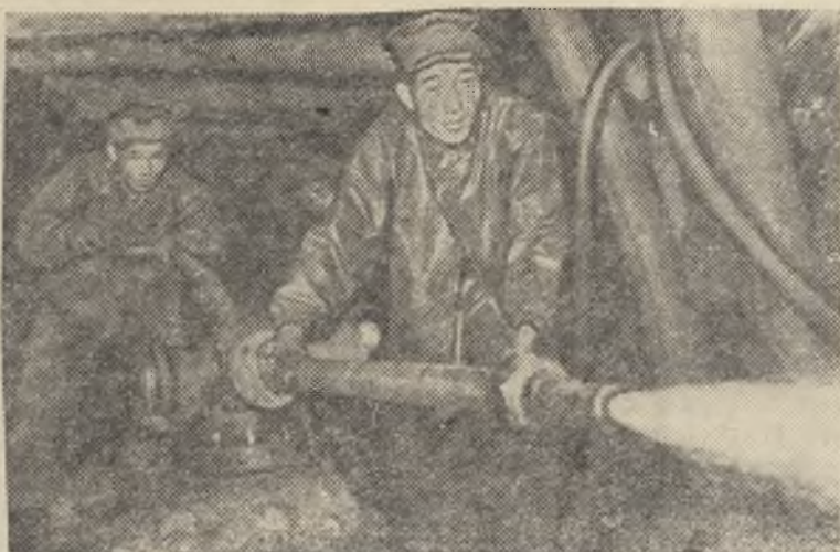
Корейская Народно-Демократическая Республика. На шахте Хёнвон в провинции Южный Пхенан добыча угля осуществляется с помощью гидромониторов. НА СНИМКЕ: гидродобыча угля на шахте. Фото Хан Чон Сика. Фотохроника ЦТАК.
