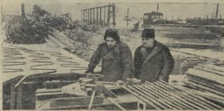
На строительстве Сталинградской ГЭС.
