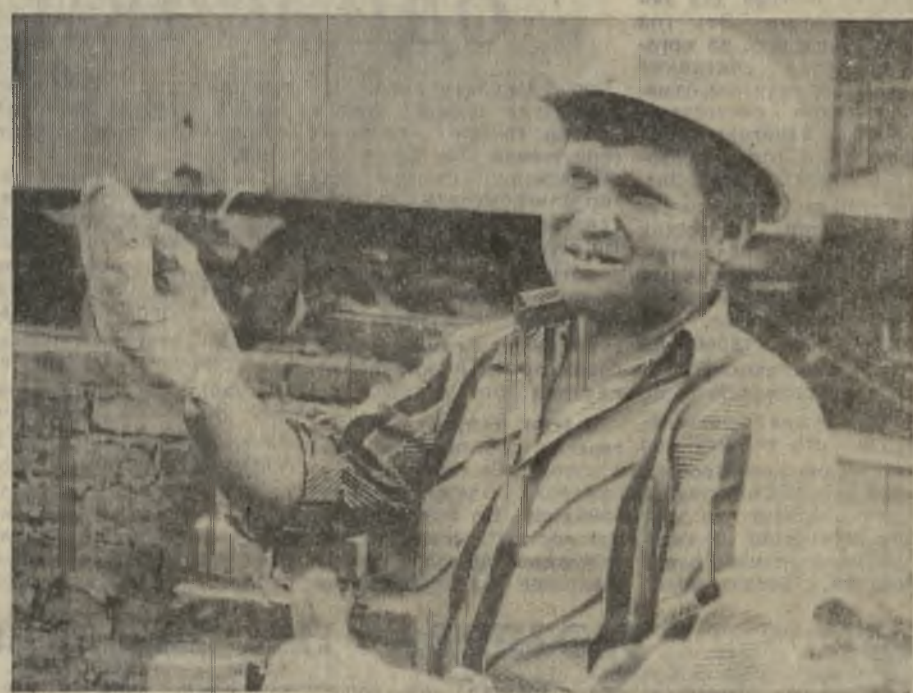
Заканчивают столовую цехов № 15 и № 16 работники ОКСа механического завода. Это будет удобное помещение с красивым интерьером. Немалый вклад в строительство внес и каменщик Рамиль Шамильевич Мубаракшин (на снимке).
