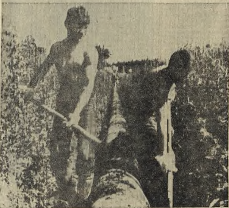
На снимке: бойцы бригады Ю. Герлица на очистке газопровода. Фото С. Аюпяна.
